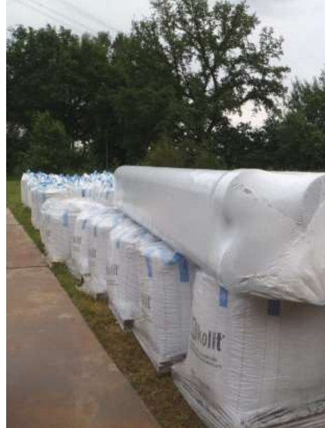
Foto 16. Opslag van stijgbuizen en peilfilters (foto WML)
