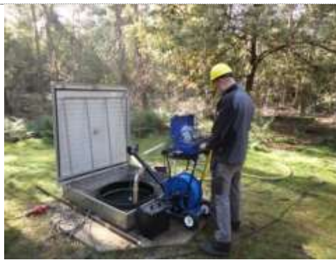
Foto 30. Camera inspectie (foto Brabant Water)
