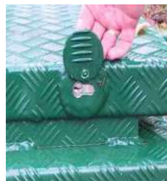
Foto 34. Beveiligde winput (foto Vitens)
