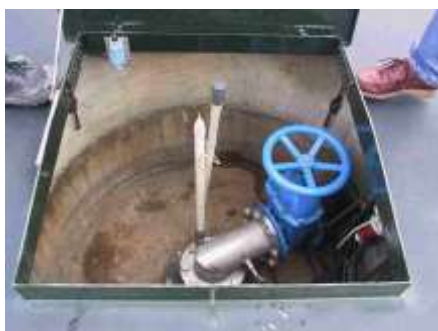
Foto 33. Beveiligde winput (foto Vitens)
