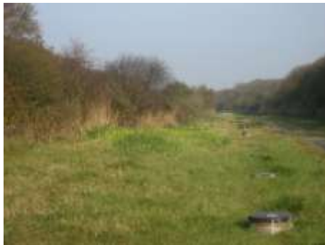
Foto 5. Verzamelputten drain (foto KWR)
