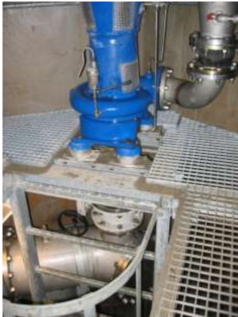
Foto 9. Horizontale put Druuten tijdens aanleg (foto Vitens)
