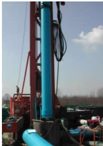
Foto 18. Inbouw PVC pompkamer (foto Brabant Water)
