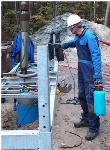
Foto 13. Desinfectie van een pomp (Foto Brabant Water)
