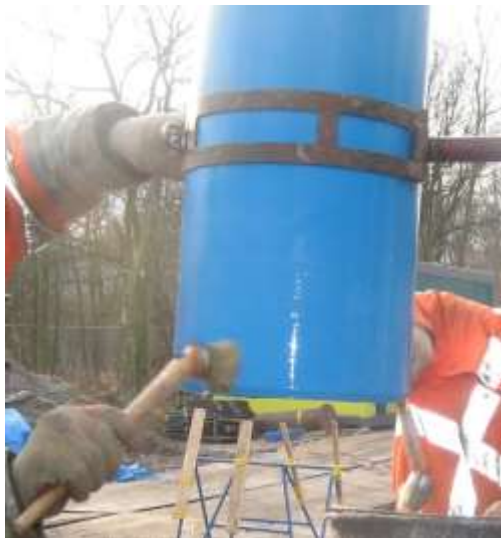
Foto 17. Lijmen spie-eind en mof (foto Brabant Water)
