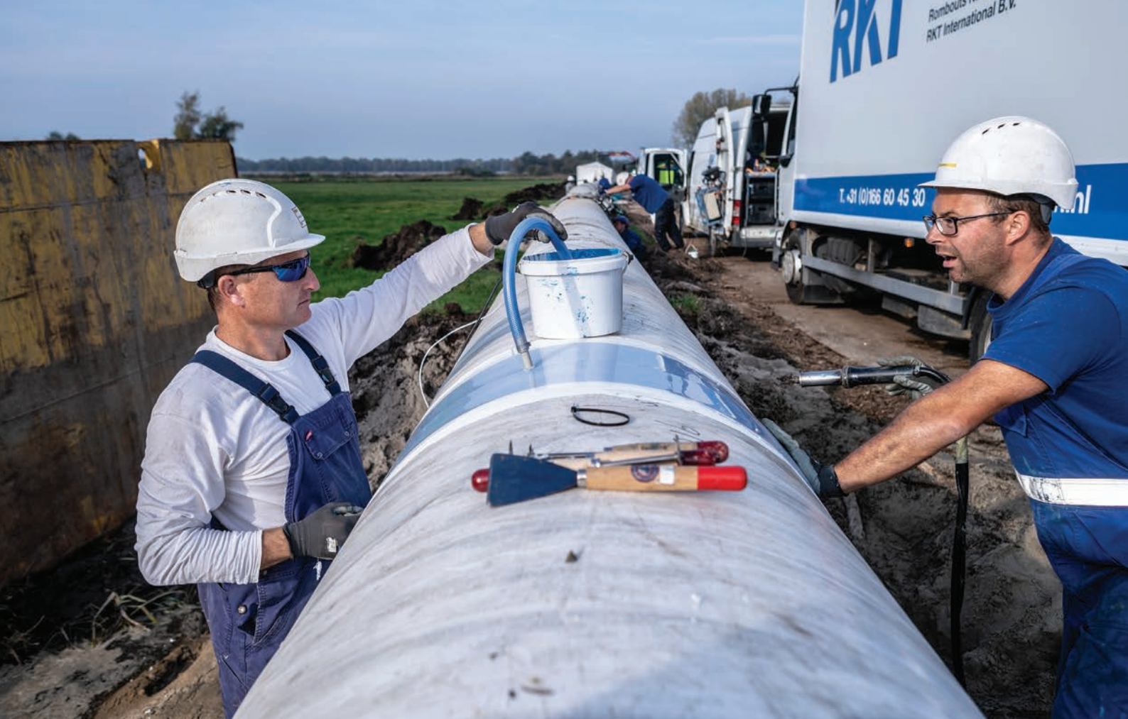
Aanleg van een nieuwe hoofdtransportleiding bij Haren. (Foto: Duncan Wijting).
