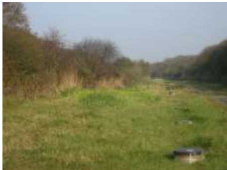
Foto 5. Verzamelputten drain (foto KWR)
