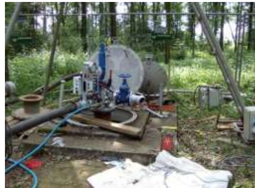
Foto 26. Regeneratiewerkzaamheden (foto Brabant Water)
